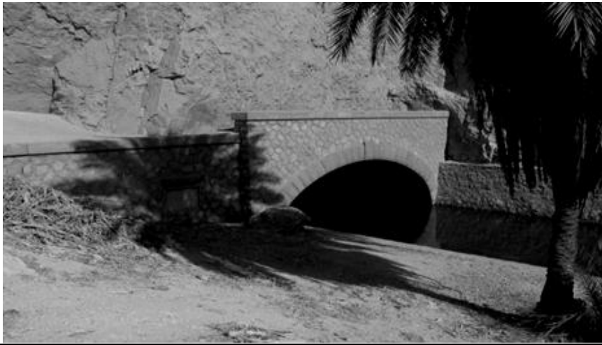
(لوحة ١١) صورة توضح واجهة المدخل الجنوبي للنفق.
