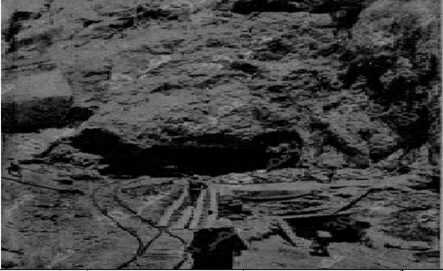
(لوحة ٦) صورة توضح تجهيز الموقع للحفر وتركيب خطوط الديكوفيل الذي كان ينقل عليه الأحجار وناتج الحفر؛ عن لوحة ٦، مجلة المصور.
