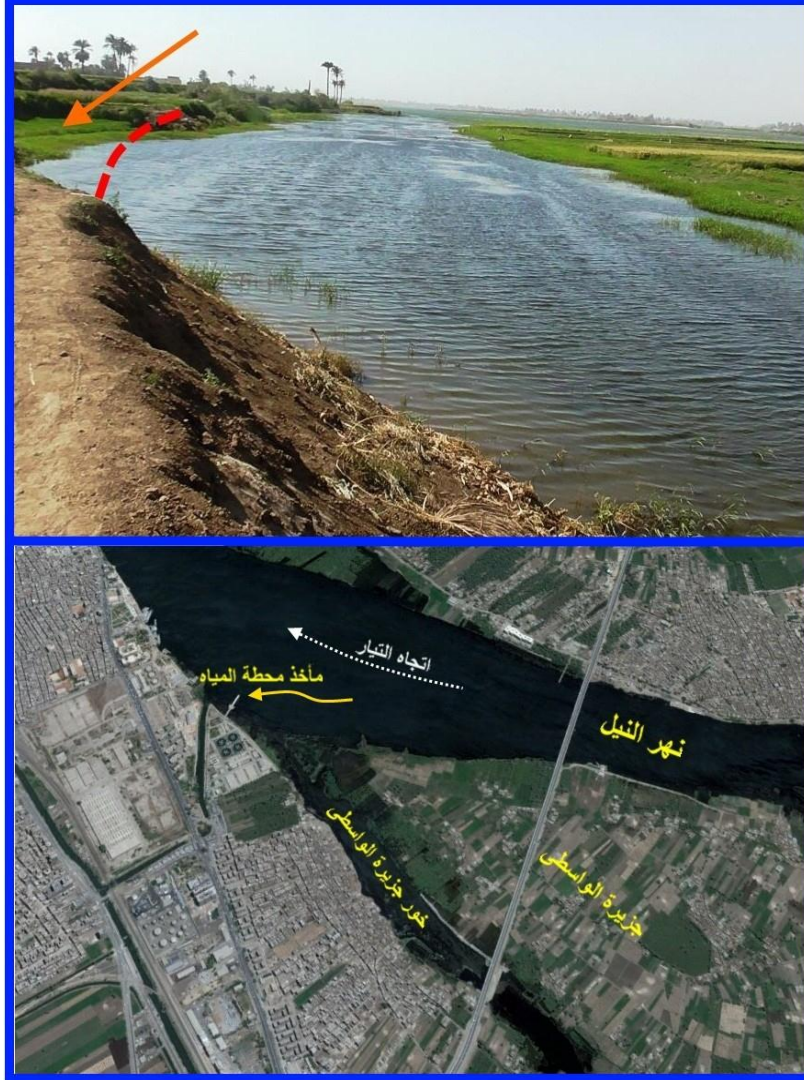
صورة (٧) انهيار بعض الأجزاء من ضفة خور شرق نجع صالح عبد الله في الصورة العليا، وموضع مأخذ محطة مياه أسيوط بالقرب من ذراع جزيرة الواسطي في الصورة السفلى
