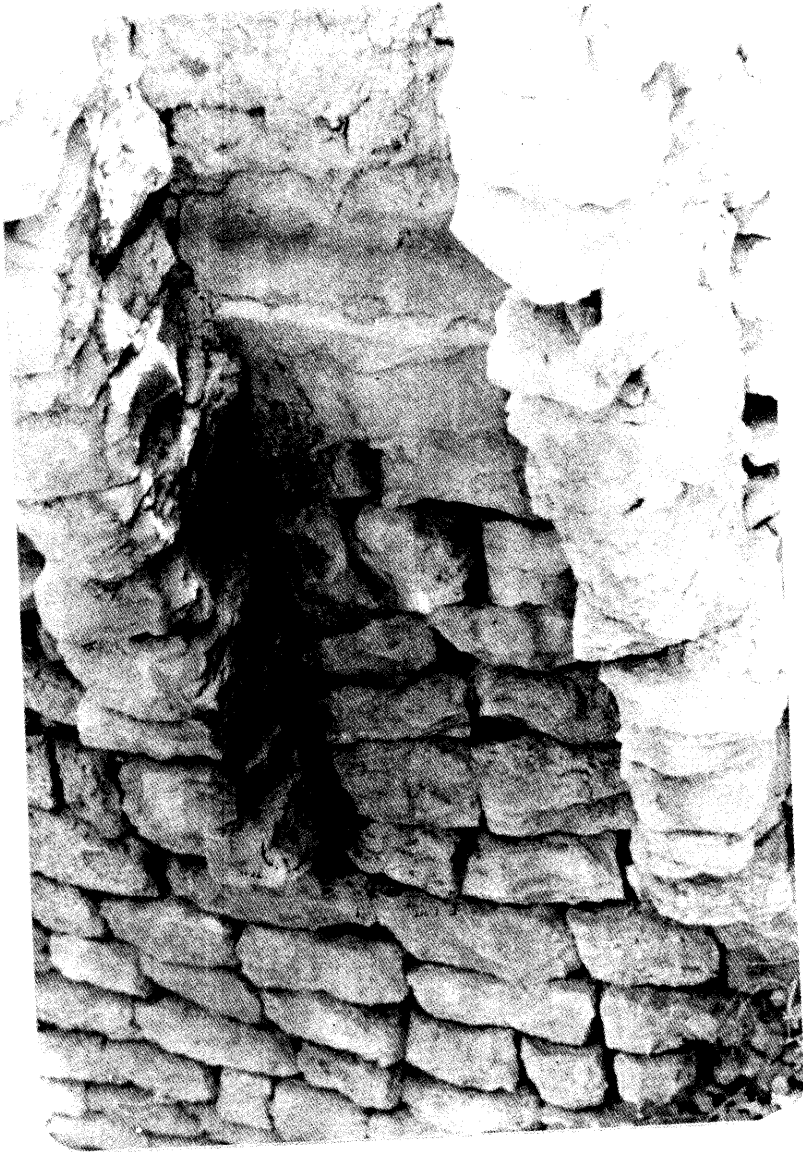
لوحة رقم ( ١٤ ) تبيين بناء الزرانيق التى على جانب البئر وإرتباطها بطى البئر الحجرى
