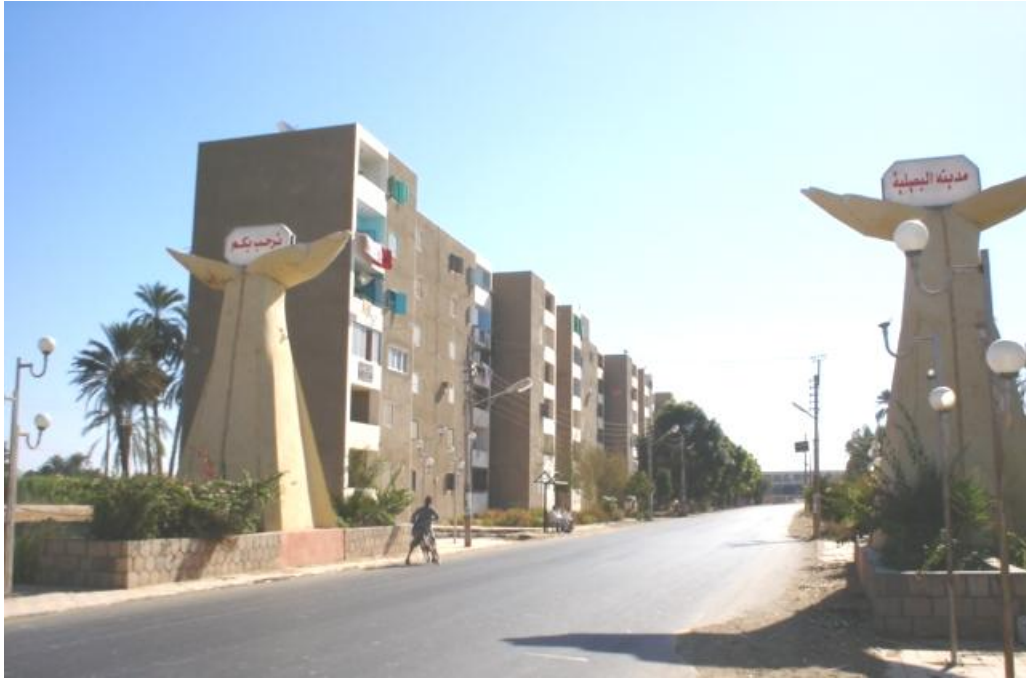
صورة ( ١٠ ) مدينة البصيلية بحري: الشارع الرئيسي (إدفو/ إسنا ) ومباني الوحدة المحلية متوسطة التكاليف
