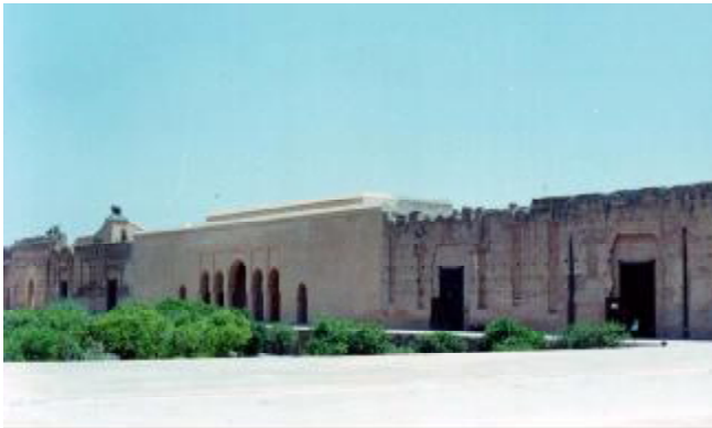
(لوحة ١٢) الواجهة الجنوبية لصحن القصر، تصوير الباحث.
